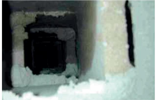
Las juntas de mortero fueron rehundidas con junteador para evitar micro-fisuras y asegurar el confinamiento del mortero.
