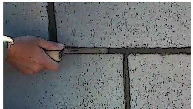
Dicho rehundido permitirá obtener juntas resistentes a la penetración del agua de lluvia, y favorecerá a la resistencia del conjunto, aumentando la adherencia BH-mezcla de asiento.
