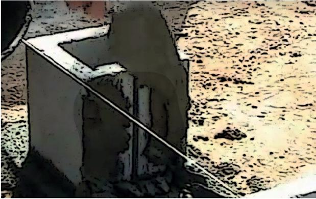
El mortero de la junta vertical debe ser aplicado a ambos lados del bloque antes de su colocación.
