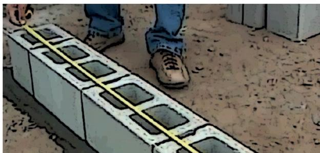
Esta primera operación en seco también permite verificar la modulación para el montaje de las aberturas. Para ello, el albañil removerá los bloques de los sectores donde deberán luego ubicarse las aberturas, y verificará que el espacio libre así logrado sea el indicado en los planos.
