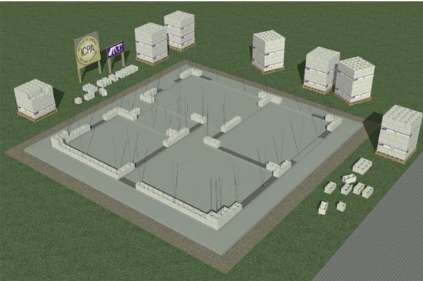
Colado del hormigón de la platea de fundación y las vigas portamuros.
