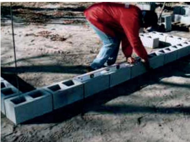
Una correcta modulación en obra permite, además, replantear correctamente las barras verticales previstas en el plano de la estructura.
