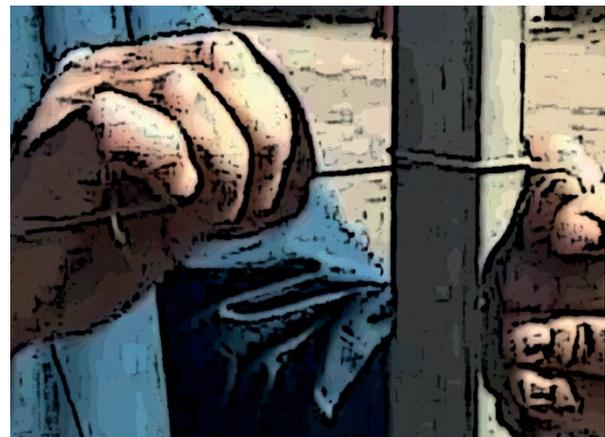
Luego, comenzando por las esquinas, el albañil presentará la primera hilada a junta seca (sin mortero, dejando una junta libre de 1 cm de espesor) a fin de verificar la correcta modulación del tramo.
