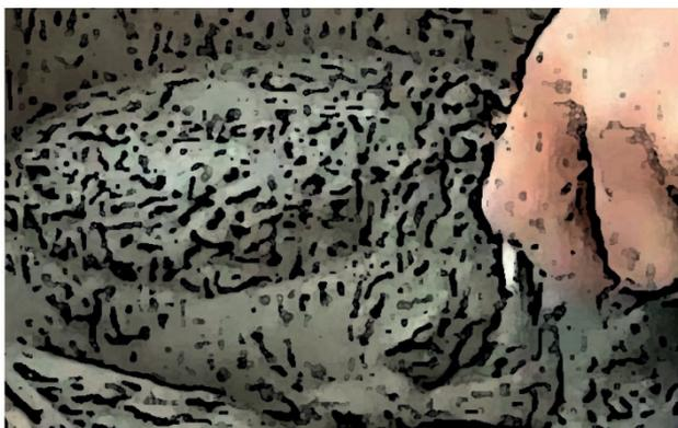
Si el mortero es muy flojo o no tiene cuerpo, no será capaz de soportar el peso del bloque y la junta no será del ancho requerido.
