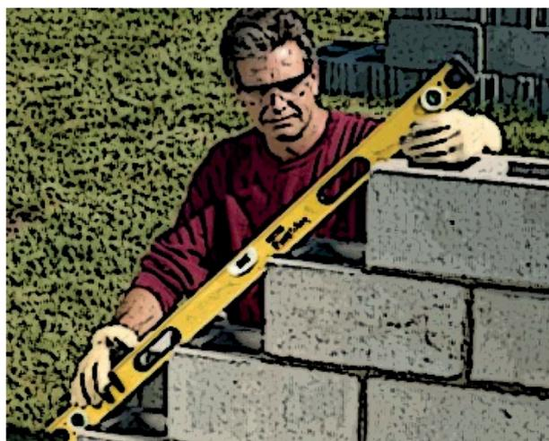
Es recomendable comenzar a levantar las hiladas superiores comenzando por las esquinas. De este modo se asegura el escuadramiento de perímetro y se facilita el levantamiento de las sucesivas hiladas, garantizando una correcta modulación horizontal. Esto implica que, en cada hilada, el último bloque a colocar (bloque de cierre) requerirá mayor atención por parte del albañil al correcto llenado de las juntas con mortero.
