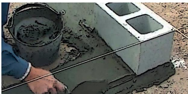
Cada bloque debe ser asentado en la pared respetando una altura constante en la junta horizontal.
