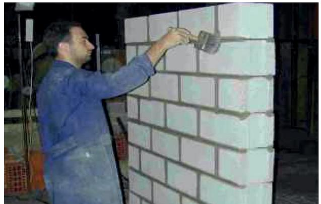
En condiciones de mucho calor o baja humedad ambiente las juntas deberán curarse, pincelándolas con agua.
