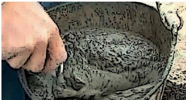
Para corroborar si la consistencia del mortero es la correcta, se utiliza la pala o cuchara, removiendo la mezcla dentro del balde y verificando que la misma se desplace fácilmente.
