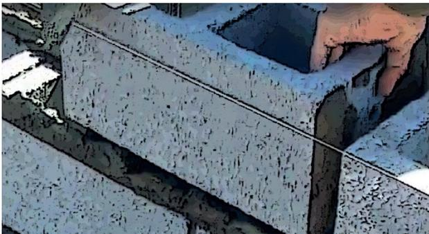
El mortero debe ser presionado sobre los bordes del **BH** para evitar que se caiga al ser levantado.
