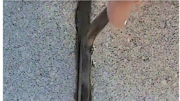
Las juntas del lado exterior del muro deben ser rehundidas con forma cóncava o en "V"
